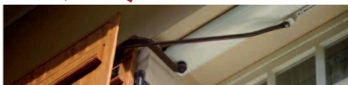
Le compas est réalisé sur-mesure à la couleur des bras et coulisseaux
