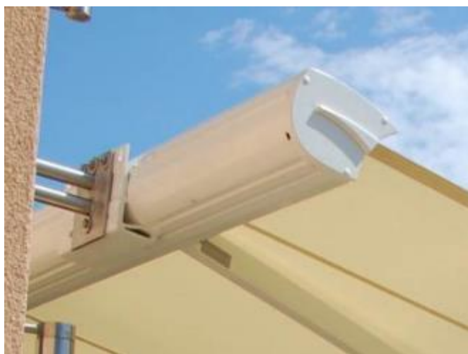
Exemple de pose marginale Support personnalisé en inox
