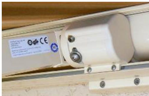
Support intermédiaire avec visserie inox
