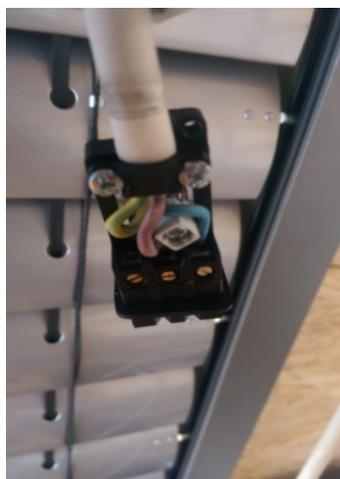
Le fil terre reste en place, le neutre en bleu est à droite, la phase en marron sera au milieu, la terre en jaune/vert sera à l'arrière sur une vis à part et le câble noir devra être débranché et isolé.
